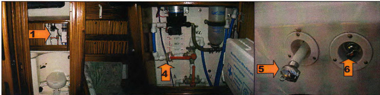
77. Wassertankumschaltung, Toilette bb achtern
